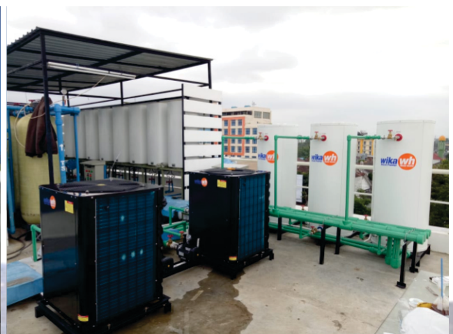
Proyek Ayaartta Hotel, Yogyakarta - Perbaikan Sistem Water Heater Listrik Menjadi Water Heater Heat Pump Wika
