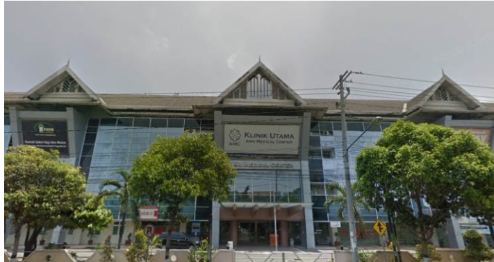
Proyek Ruang Ok, Ruang Cito, dan ICU - RS AMC Muhammadiyah
